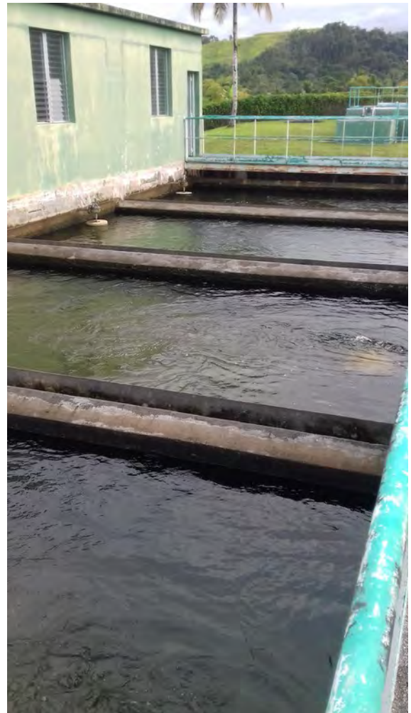
Photo n° 7 : usine de potabilisation de Moustique : décanteur lamellaire et filtres à sables (source : mission)
